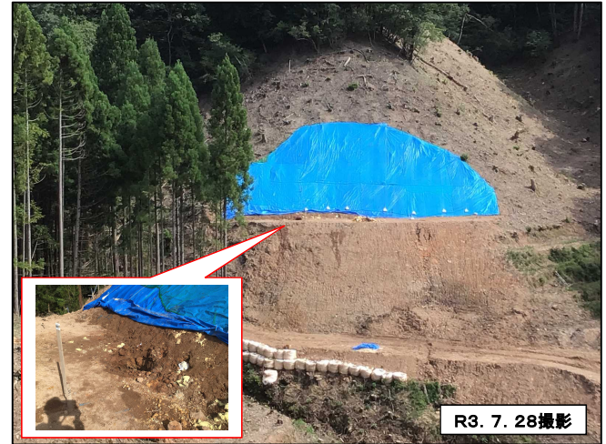
トンネル坑外貫通後 (上佐野側)
