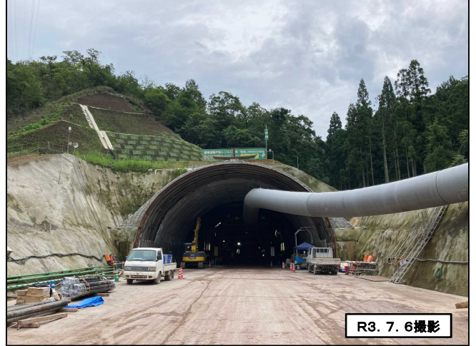
掘削後 (戸牧側)
