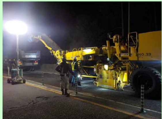
舗装修繕工事
