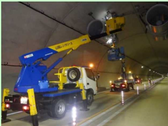
トンネル換気設備点検
