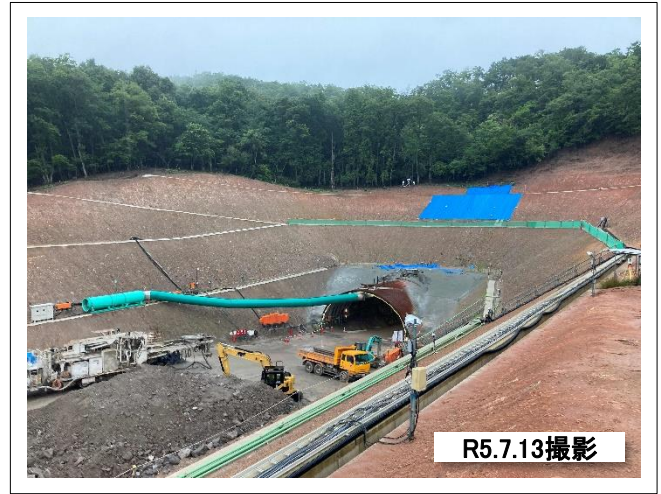
掘削後(南側/但馬空港IC側)
