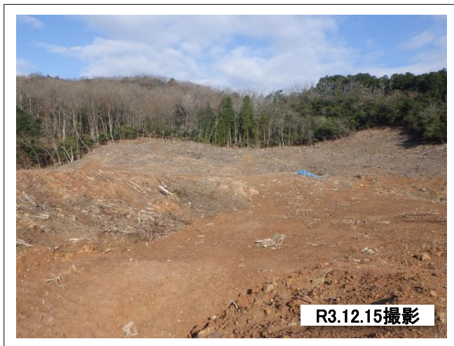
掘削前(南側/但馬空港IC側)
