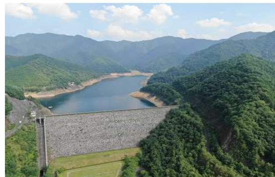
多々良木ダム(関西電力)
