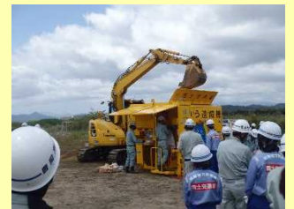
<土のう製造機による 土のう作成>
