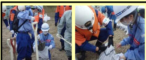
1. 土のう袋に土を入れ、袋を縛ります。
