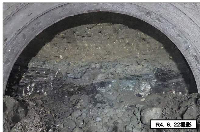
トンネル内貫通前
