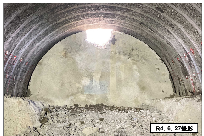
トンネル内貫通後
