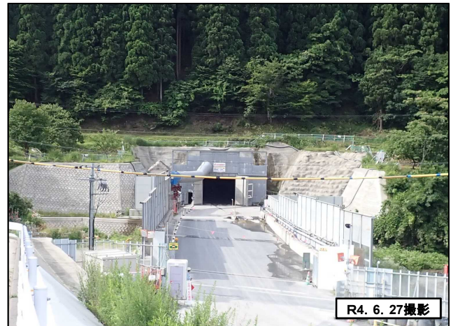
掘削後 (日影側)
