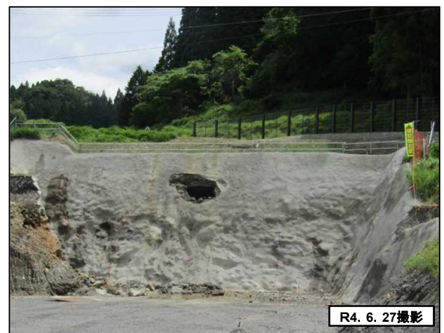
トンネル坑外貫通後 (黒田側)
