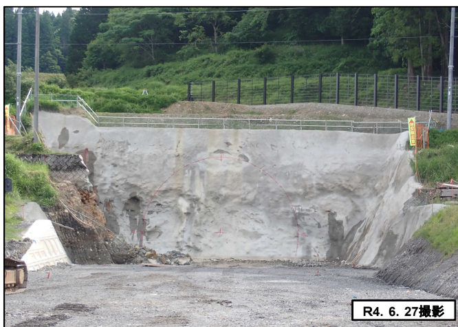
トンネル坑外貫通前 (黒田側)
