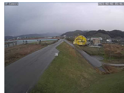
立野地点簡易型河川監視用カメラ画像
