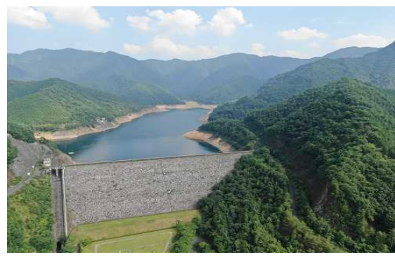
多々良木ダム(関西電力)
