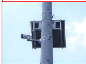
円山川5.50k付近(左岸)来日地区
