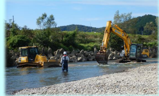
重機を使用し産卵場を造成、その後に人力による耕うんを行いました！！
