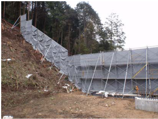
防音シートの設置（三谷地区）
