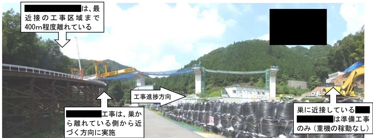
図 6-1 に近接した工事の実施状況（H26.7調査時撮影）
