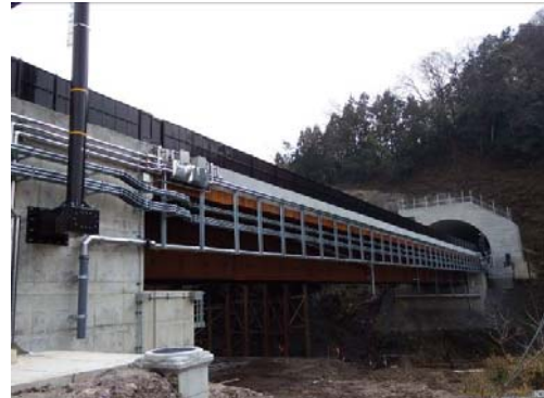
周辺景観との調和に配慮した桁の色彩 (久斗地区・稲葉川橋)
