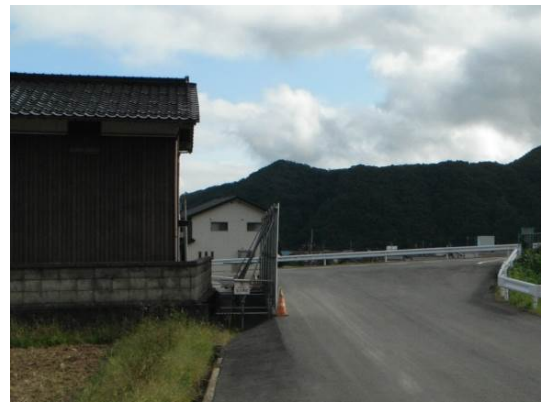
万能塀（防音壁）の設置（浅倉地区）
