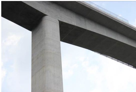
橋脚の面取り (宿南地区・青山川橋)
