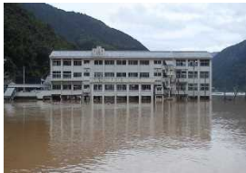
H26. 8 避難所2階の浸水(徳島県)
