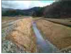
緩傾斜護岸のイメージ (コウノトリの郷公園前)
