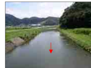
中江井堰から上流部の状況 コンクリート護岸により水域と陸域の連続性が分断されている
