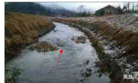
馬路川の状況 法枠コンクリート護岸となっている 河床の一部に植生も見られるが、馬路川橋付近はコンクリート三面張である
