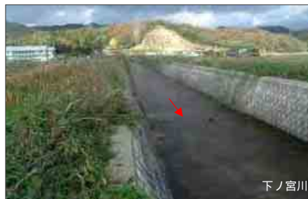
下ノ宮川の状況 コンクリート三面張りである
