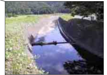
濁水時の取水の状況。 井堰の下流は河川流量がない
