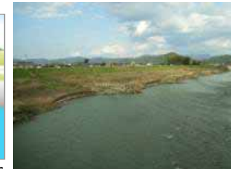
上ノ郷橋付近左岸の水制工
