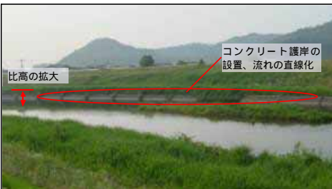
現在は流れも直線化し、コンクリート護岸の設置に伴い自然河岸が消失している。また、全川的に河床低下の傾向がみられ河川水位と高水敷高との比高も拡大している。
