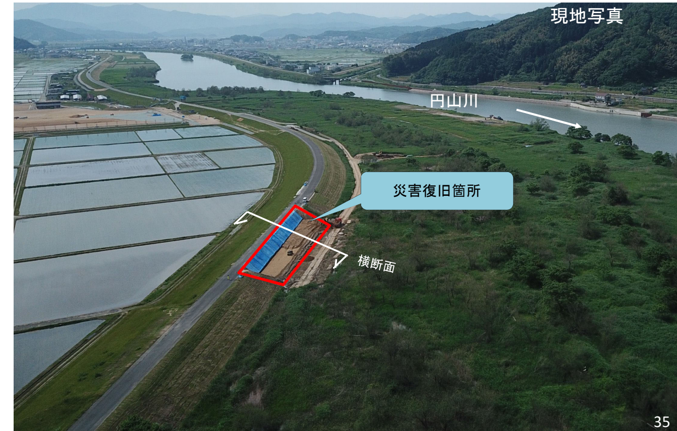
参考3. ひのそ地区特殊堤整備工事 工事箇所: 赤石地区7.8k付近右岸
