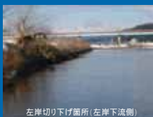
左岸切り下げ箇所(左岸下流側)
