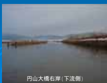
円山大橋右岸(下流側)
