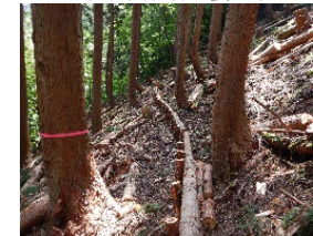
丸太筋工の実施 (林野庁 兵庫森林管理署)
