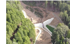
砂防堰堤の設置 (兵庫県 養父土木事務所)
