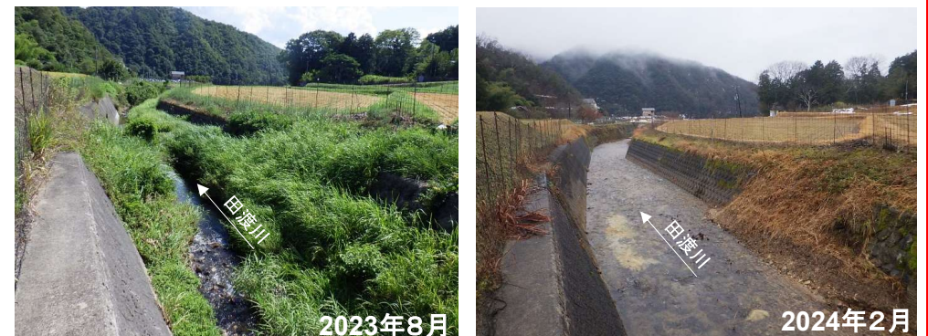
普通河川 堆積土砂撤去
