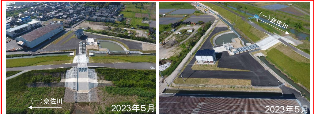
山田川流域内水対策事業 福田排水機場整備
