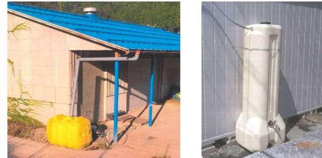
雨水貯留槽設置事例
