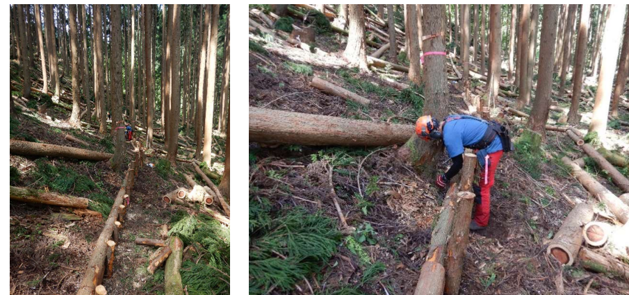
横行国有林の土壌流出防止対策の丸太筋工(6月)
