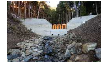
部分透過型治山ダムの設置 (兵庫県 朝来農林振興事務所)
