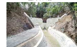
砂防堰堤の設置 (兵庫県 豊岡土木事務所)
