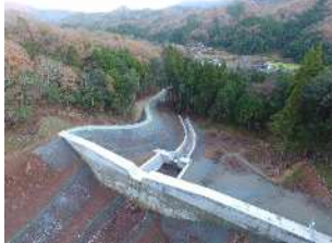
砂防堰堤の設置 (兵庫県 豊岡土木事務所)
