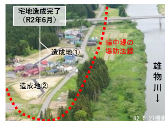
移転先宅地造成完了状況
