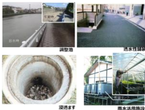
雨水貯留浸透施設の例
