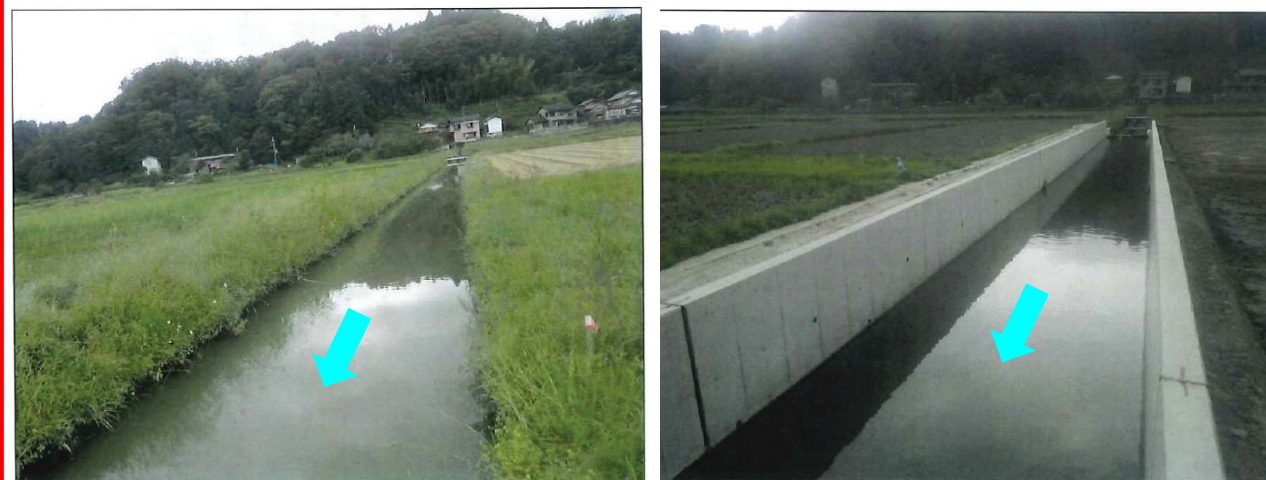
山田川雨水幹線整備（令和4年4月及び令和5年1月撮影）
