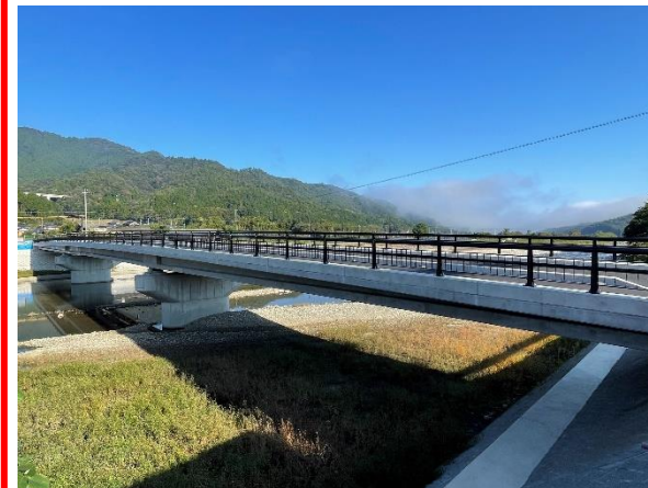
新たに完成した出合橋(市道物部伊由市場線)
