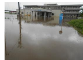
浸水時の状況 (喜多方市提供)
