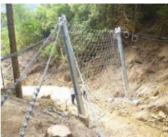
ワイヤーネット工の活用
