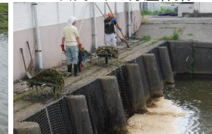
スクリーンの除塵作業
