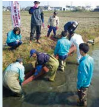
④ 集落総出で魚道を設置
