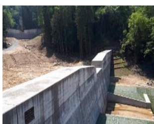
土石流の衝撃に対応する断面の厚い治山ダム
