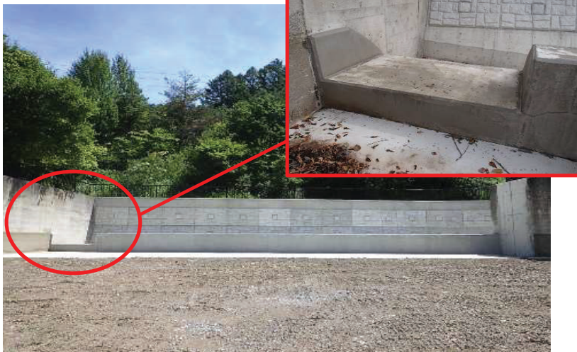
洪水吐きスリットの設置の例
