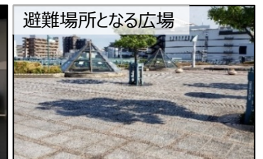
屋上の広場は浸水時に一時避難場所として活用
