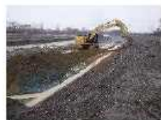
河道掘削 (石狩川水系、北海道開発局)
