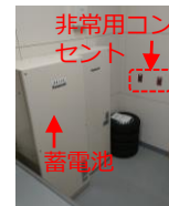
利用施設における再生可能エネルギーの導入と蓄電池の設置による非常時における電源の確保
