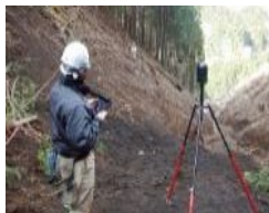
ICT施工の活用
