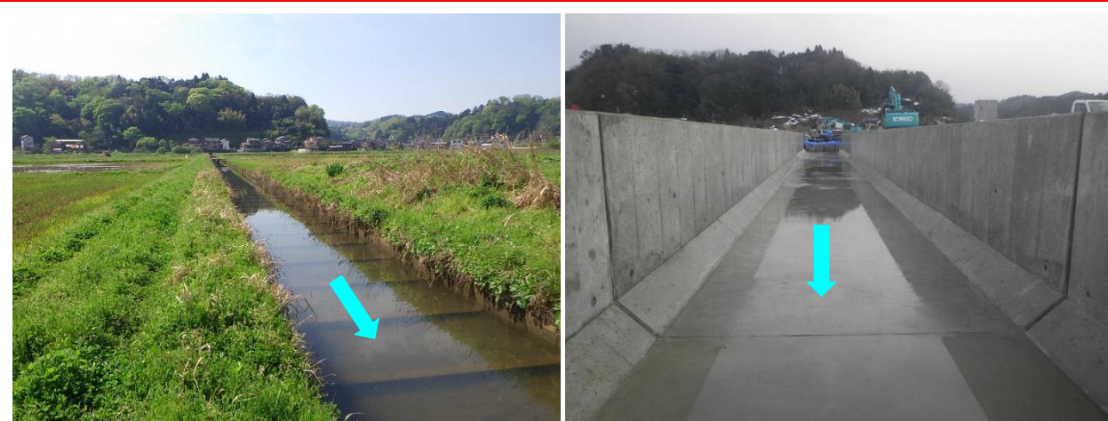
山田川雨水幹線整備 (令和3年4月及び令和4年1月撮影)
