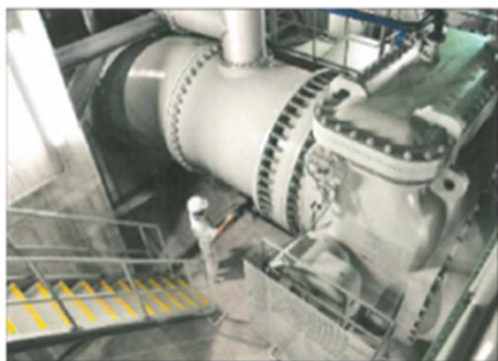
雨水ポンプの整備
