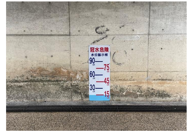
道路部アンダーパス水深標示板整備(令和3年6月整備)
