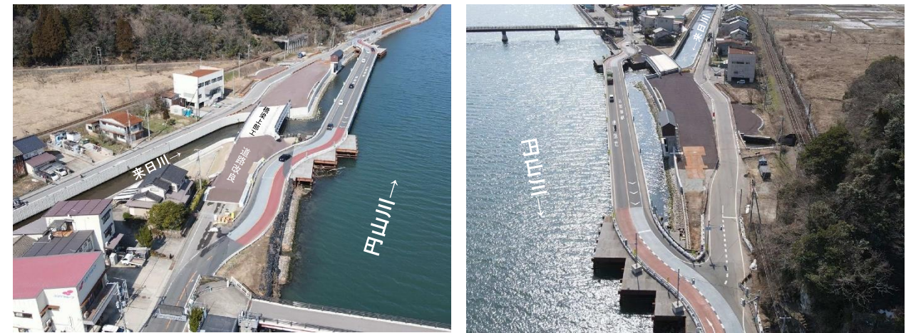
ひの其他地区堤防整備(来日川合流部)
