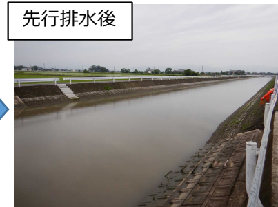
農業水利施設の整備・有効活用(クリークの使用) 【筑後川水系】
