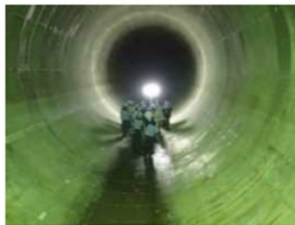
雨水貯留管の整備
