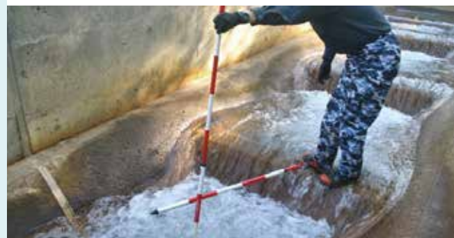
④ 魚道内(台形断面)の通水状況
