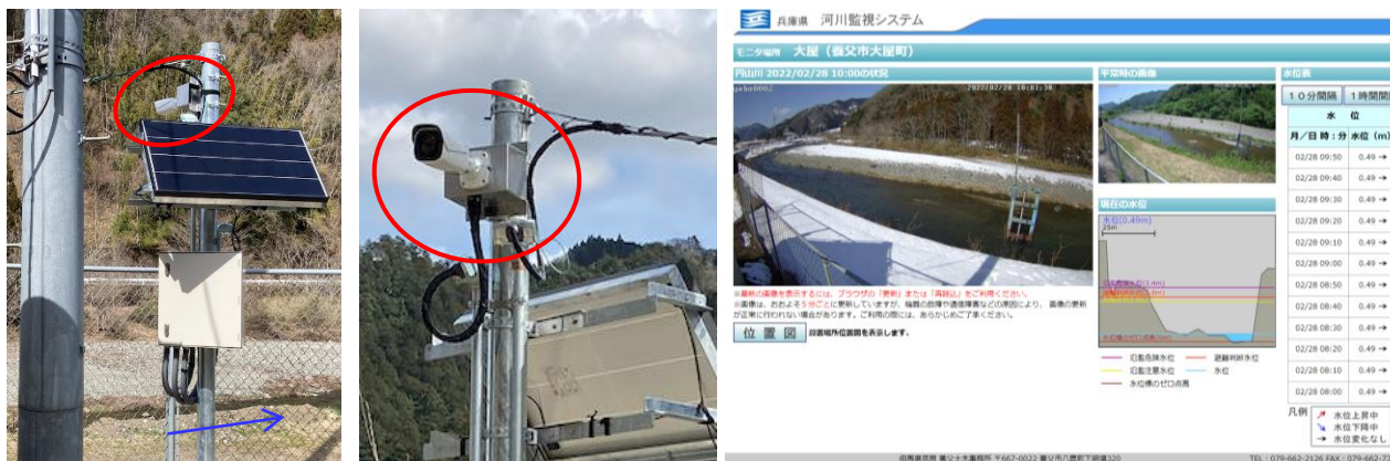
河川監視システム(円山川水系大屋川(大屋地点))
