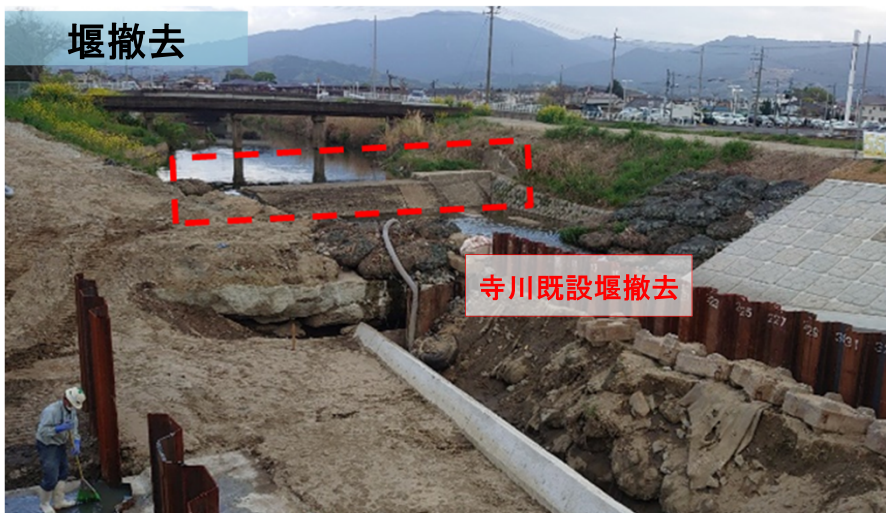
寺川堰撤去(桜井市大福工区)
