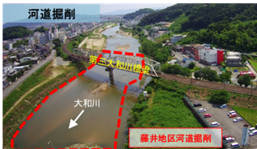
河道掘削(藤井地区)
