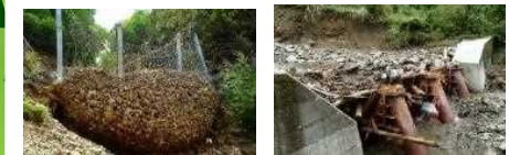
(参考) ワイヤーネットやスリットダムによる土石や流木の捕捉
