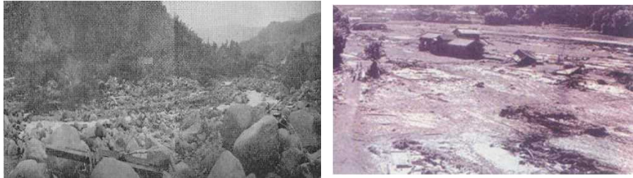
静岡県伊豆地域における溪流荒廃・洪水の発生状況
