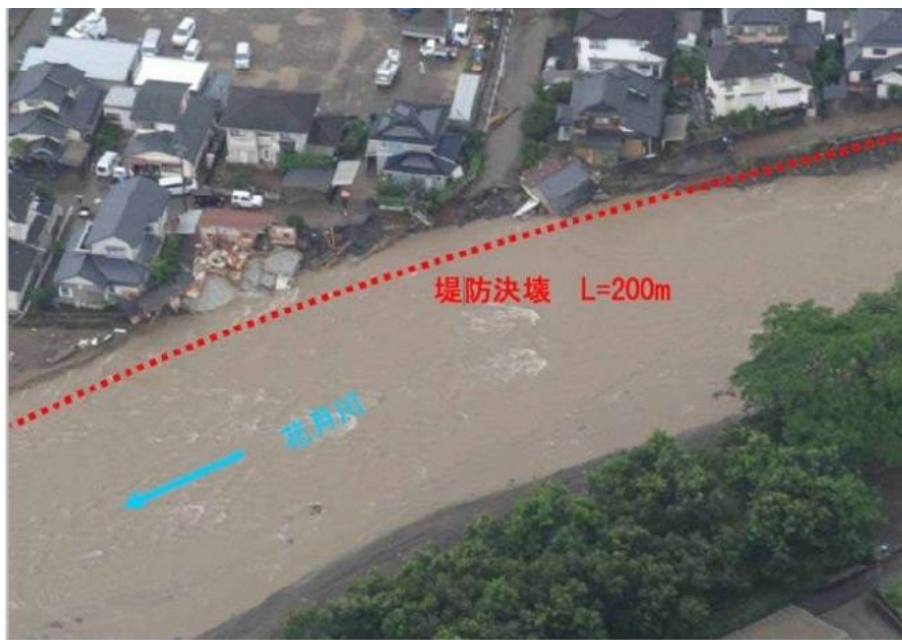
河岸侵食により家屋倒壊した状況
