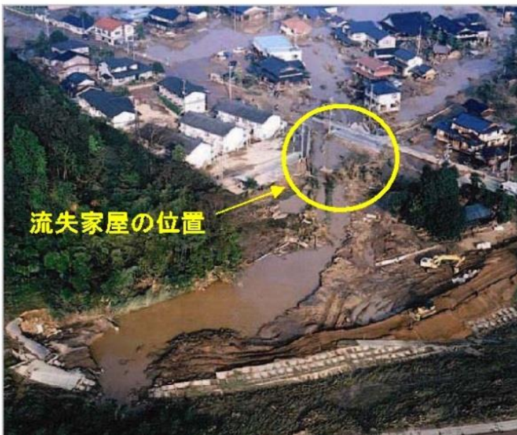
氾濫流により家屋倒壊した状況
