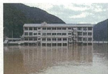
H26. 8 避難所2階の浸水(徳島県)
