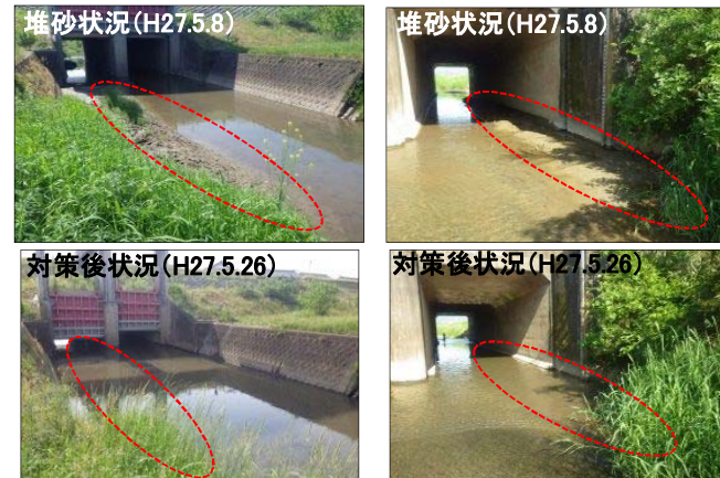
点検による樋門の堆砂状況の確認と対策後の状況
