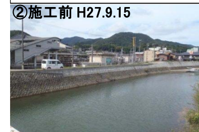
湯島地区の遮水矢板施工区
