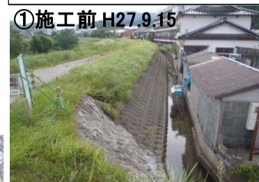
湯島地区のドレーン工施工区
