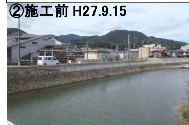
湯島地区の遮水矢板施工区間
