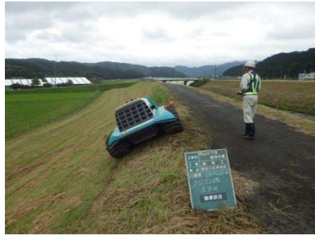
遠隔操縦式除草状況
