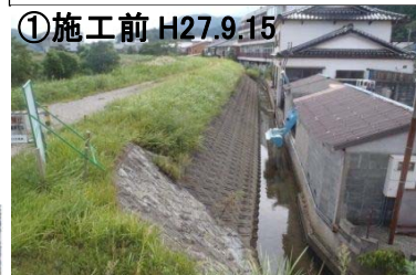
湯島地区のドレーン工施工区間
