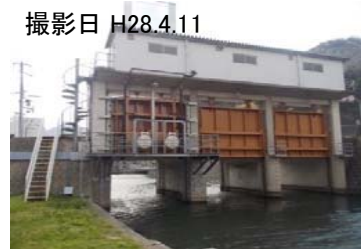
桃島樋門の施工後写真
