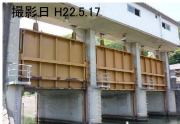
桃島樋門の施工前写真
