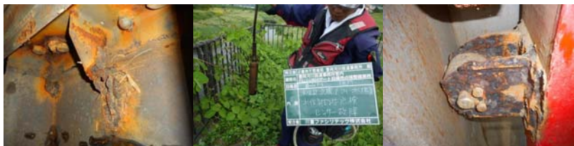
河川管理施設の点検状況
