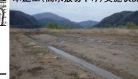
本施工(高水敷切下げ)実施状況
