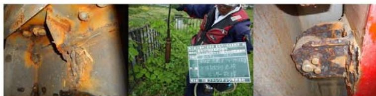
河川管理施設の点検状況
