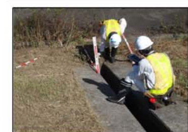
土木構造物の点検状況
