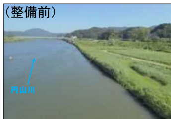
②立野大橋下流 緩傾斜化+置石
