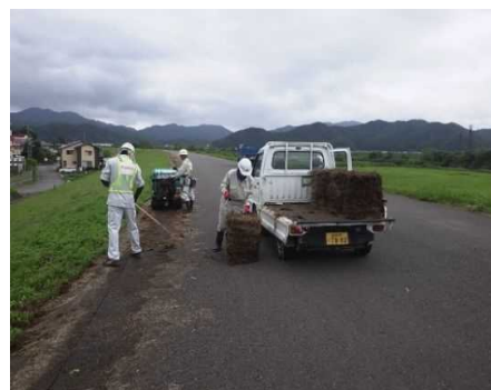
刈草ロール化・積み込み状況
