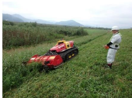
遠隔操作式除草状況
