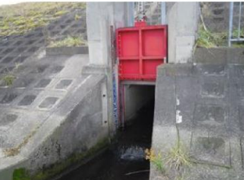
寺内第1樋門の施工前写真
