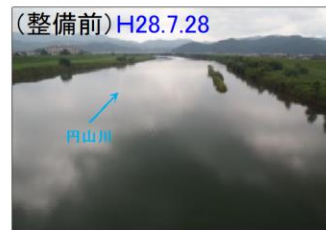
⑥円山大橋下流 緩傾斜化、半閉鎖型
