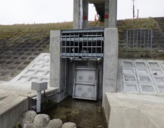
寺内第1樋門の施工後写真
