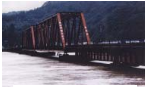
円山川鉄道橋 (平成2年9月洪水)
