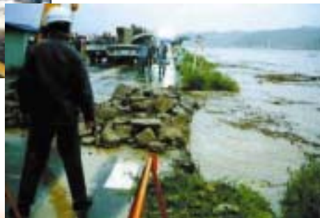
法面崩壊の応急対策(豊岡市江本付近)
