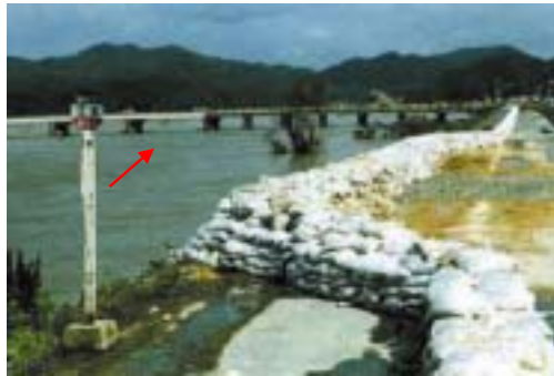
越水防止の土のう積み (豊岡市江本円山川右岸)
