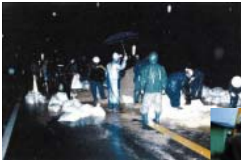
氾濫に備えた土のう積み
