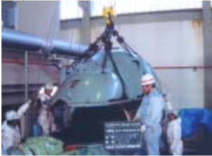
ポンプ点検の状況
