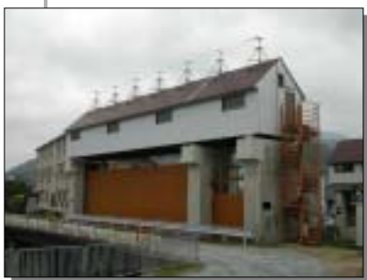
城崎水門(河川管理施設)
