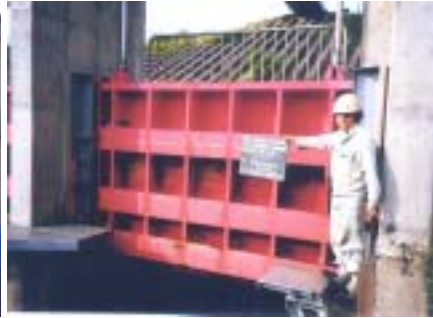
ゲート点検の状況
