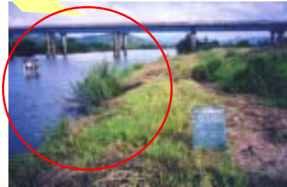
伐採施工後の状況
