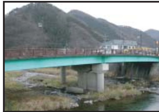
新多々良木橋
