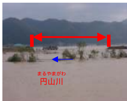
円山川立野地点破堤状況
