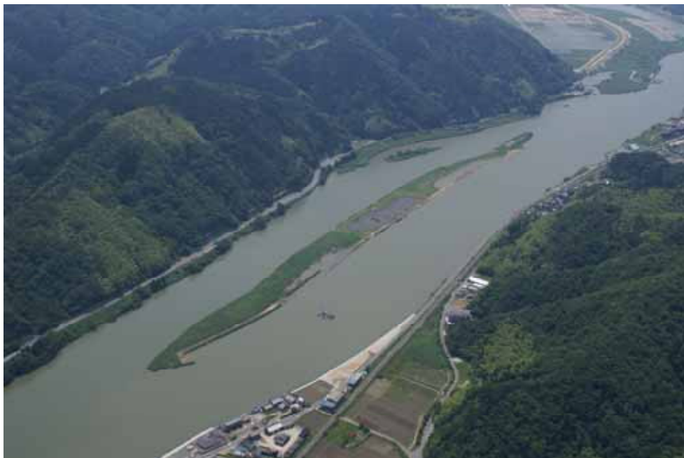
図 4.1 工事完成間近のひのそ島（平成 19 年 6 月 12 日撮影）
