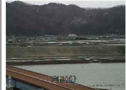
CCTV画像（立野大橋）
