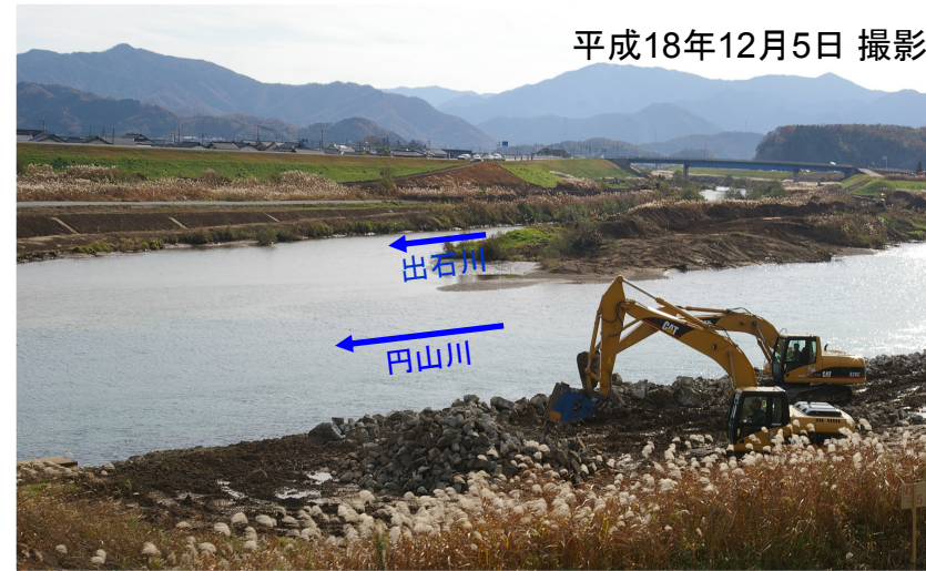
高水敷掘削(出石川合流部)
