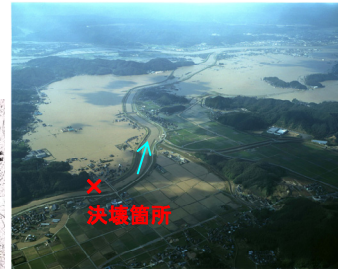
出石川左岸5.4k破堤地点
