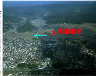
円山川右岸13.2k破堤地点
