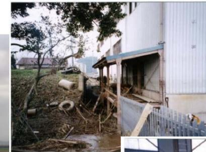
平成16年台風23号洪水により六方川排水機場(県)が浸水し、操作不能となった
