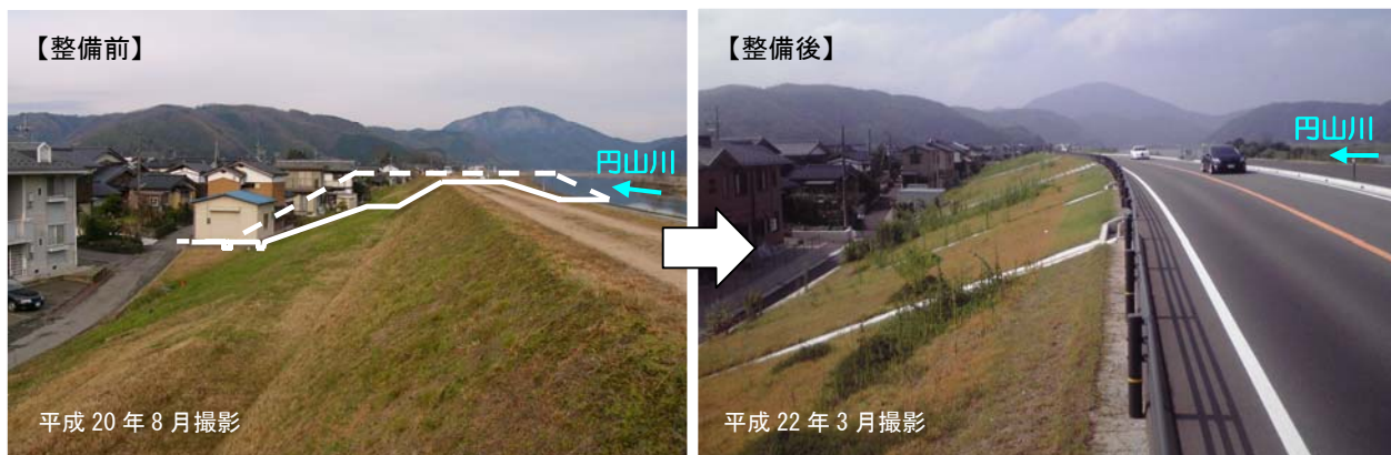
図 1.2.6 円山川堤防の嵩上げ状況 (左図の白の実線から点線の間盛土して強化した)
