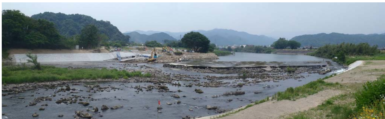
図 1.3.2 蓼川井堰（改築中 平成 24 年 6 月撮影）
