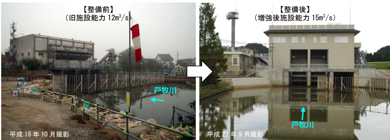
図 1.2.7 豊岡排水機場の整備状況
