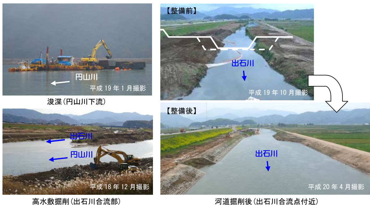
図 1.2.5 河道掘削の状況
