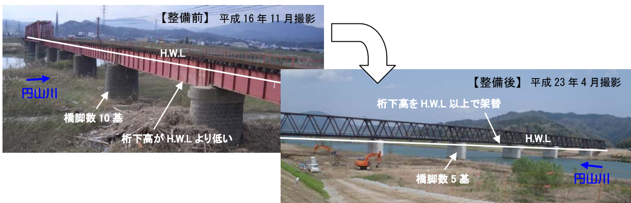
図 1.2.8 北近畿タンゴ鉄道円山川橋梁の整備状況
