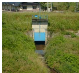
奈佐川第3樋門
