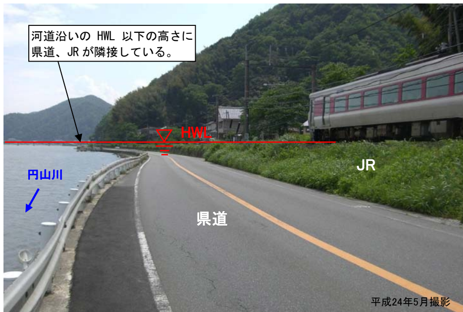
図 2.1.8 下流部無堤地区状況図 (写真：左岸 3.8k 付近)
