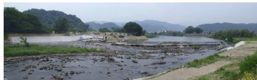
図 1.3.2 蓼川井堰（改築中 平成 24 年 6 月撮影）
