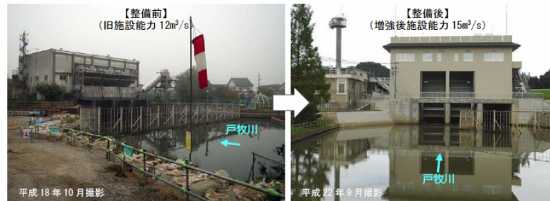
図 1.2.7 豊岡排水機場の整備状況
