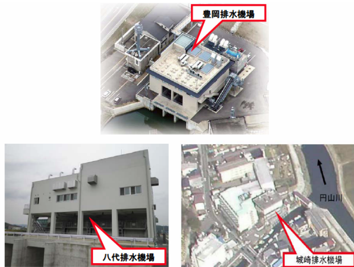
図 2.4.3 排水機場の状況
