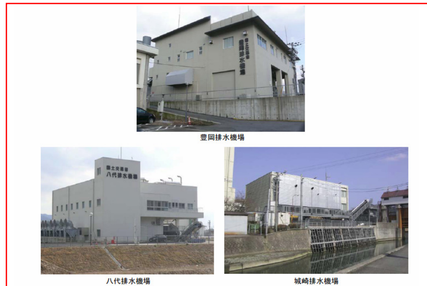
図 2.4.3 排水機場の状況
