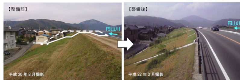
図 1.2.6 円山川堤防の嵩上げ状況 （左図の白の実線から点線の間に盛土して強化した）
