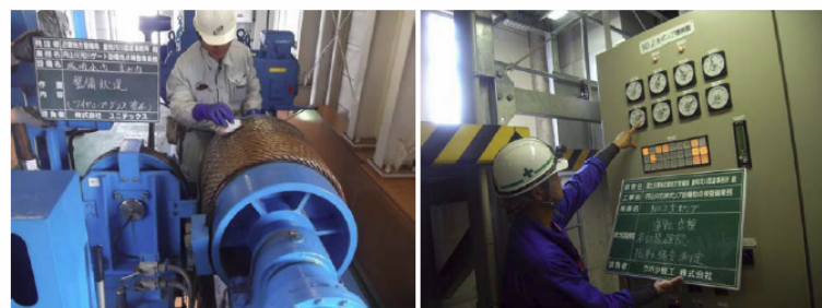
図 2.4.4 施設の点検の状況
