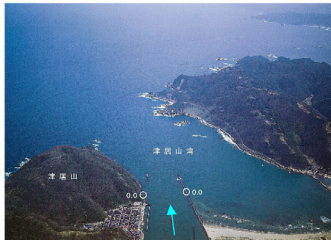
図 1.4.1 円山川上流部から河口までの状況
