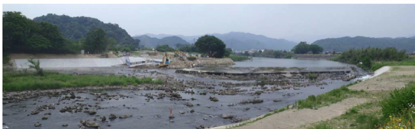
図 1.3.2 蓼川井堰（改築中 平成 24 年 6 月撮影）
