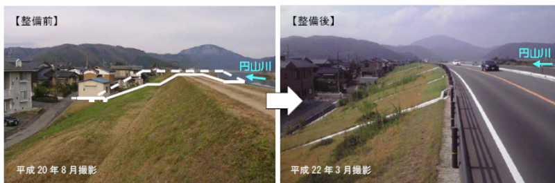
図 1.2.6 円山川堤防の嵩上げ状況
