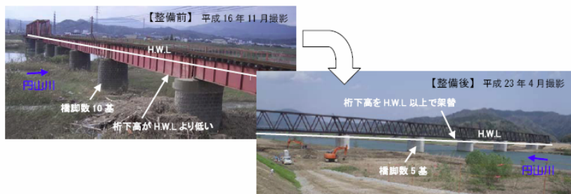
図 1.2.8 北近畿タンゴ鉄道円山川橋梁の整備状況
