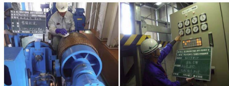
図 2.4.4 施設の点検の状況
