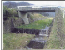
向鶴岡川落差工
