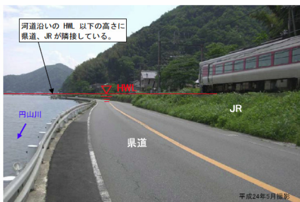
図 2.1.8 下流部無堤地区状況図（写真：左岸 8.6 k 付近）
