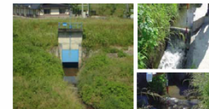
奈佐川第3樋門
