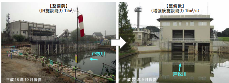
図 1.2.7 豊岡排水機場の整備状況
