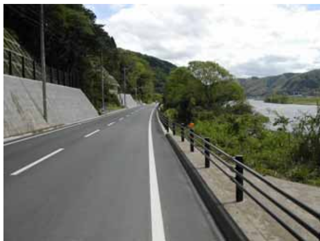
図 4.18 右岸道路の状況
