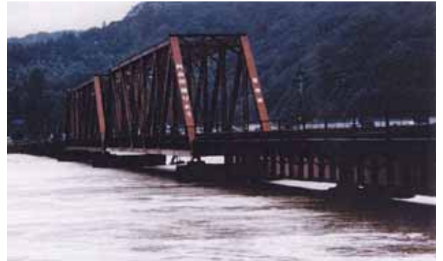
円山川鉄道橋 (写真は平成2年9月洪水) 第6回委員会資料より
