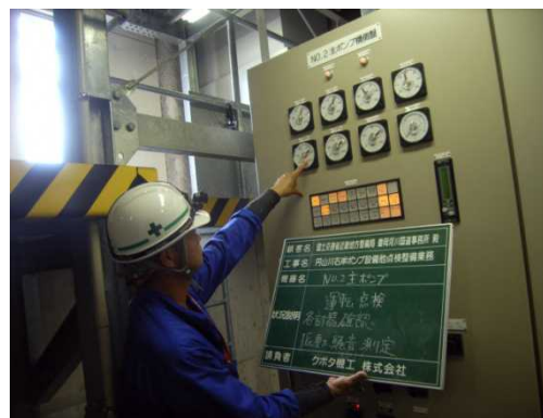
排水機場の点検状況②
