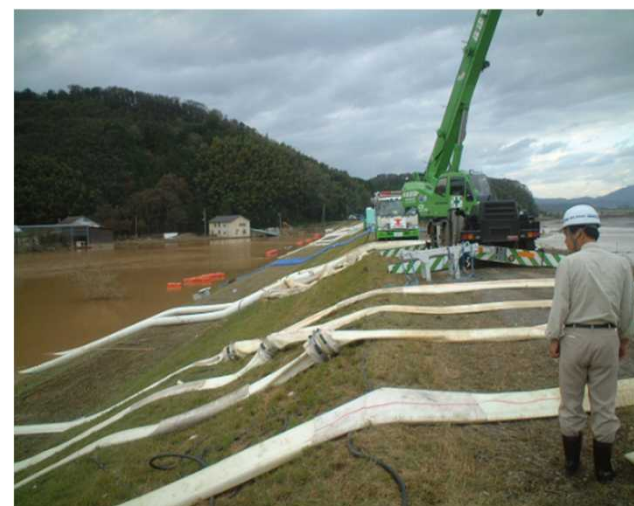
排水ポンプ車による排水状況
