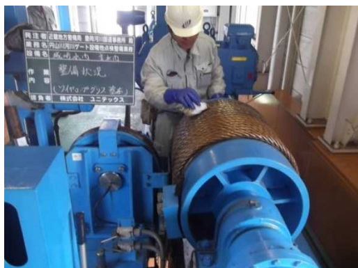
排水機場の点検状況①
