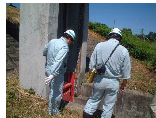
河川の点検状況
