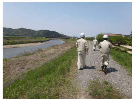
堤防点検状況①
