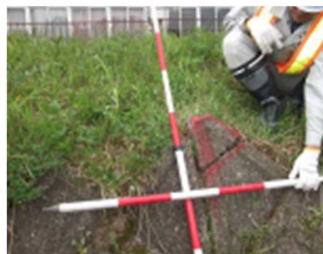
堤防点検状況②
