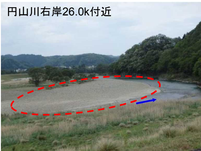
▲土砂堆積の様子
