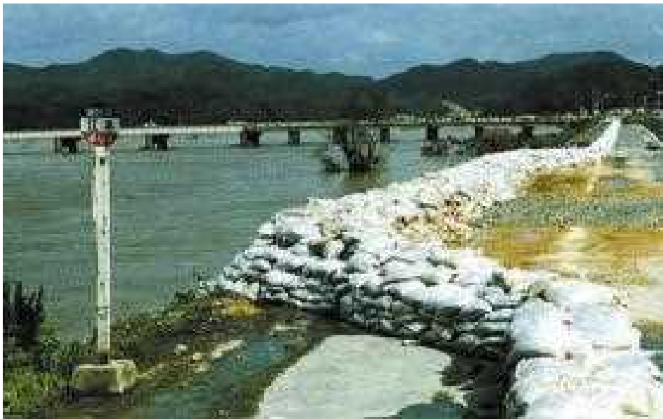
土のう積み 円山川右岸(豊岡市江本)
