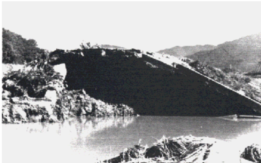
奈佐川左岸の決壊状況
