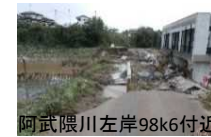
阿武隈川左岸98k6付近
