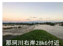
那珂川右岸28k6付近
