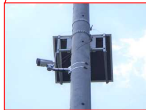
円山川5.50k付近(左岸)来日地区
