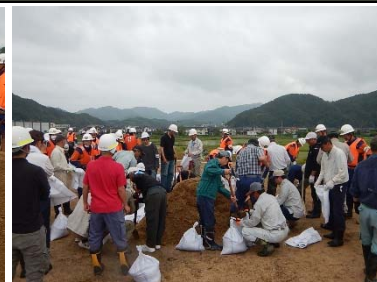
自主防災組織による土のう作成
