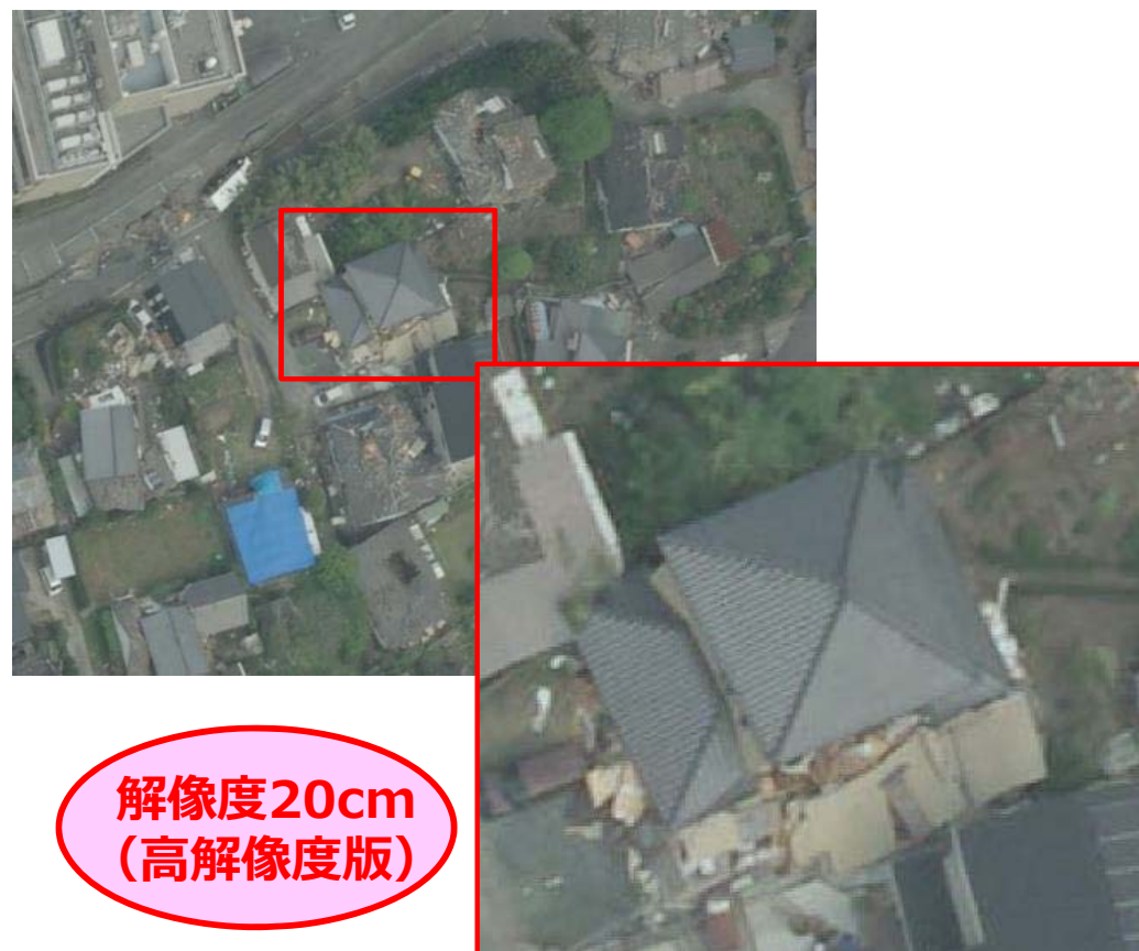
平成28年熊本地震（益城町役場周辺）
