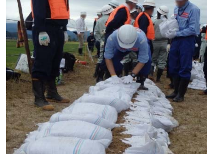
国・県・市職員による土のう積みや月の輪工法作業
