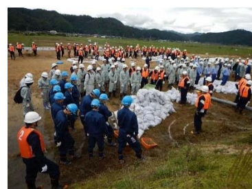
月の輪工法による 土のう積み訓練
