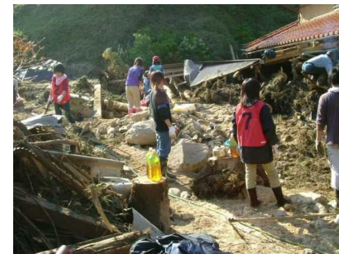
被災した家屋の後片付けに奮闘するボランティア
