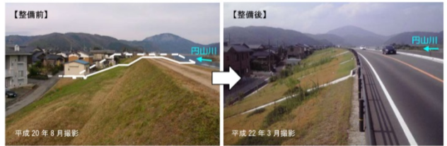
円山川堤防のかさ上げ状況
