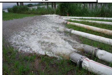
ポンプによる排水状況
