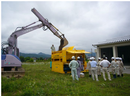
土砂をホッパーに投入
