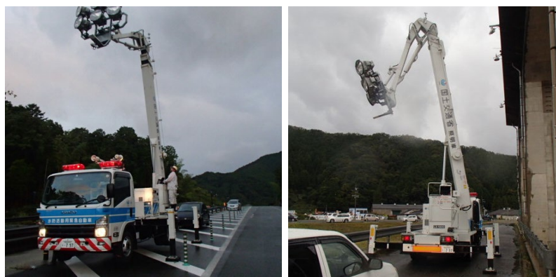
照明(2kw×6灯)作業中
