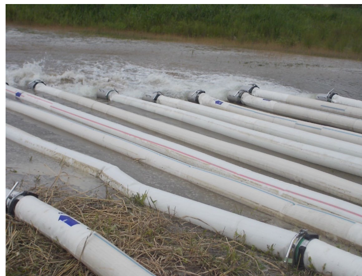
ポンプによる排水状況
