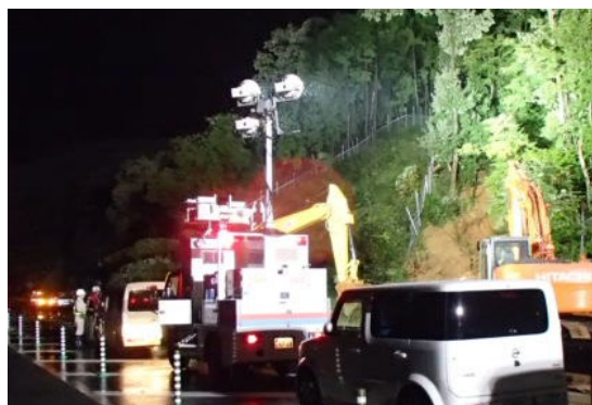
照明(2kw×6灯)作業中
