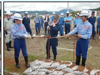
杭を打ち安定性を確保
