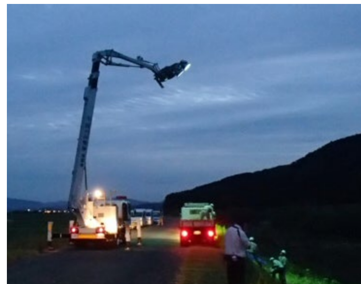
照明(2kw×6灯)作業中
