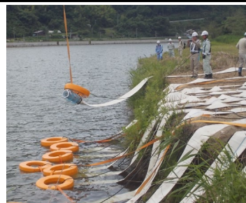
クレーンにてポンプ設置状況
