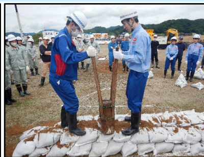
土のう袋を並べて圧をかける
